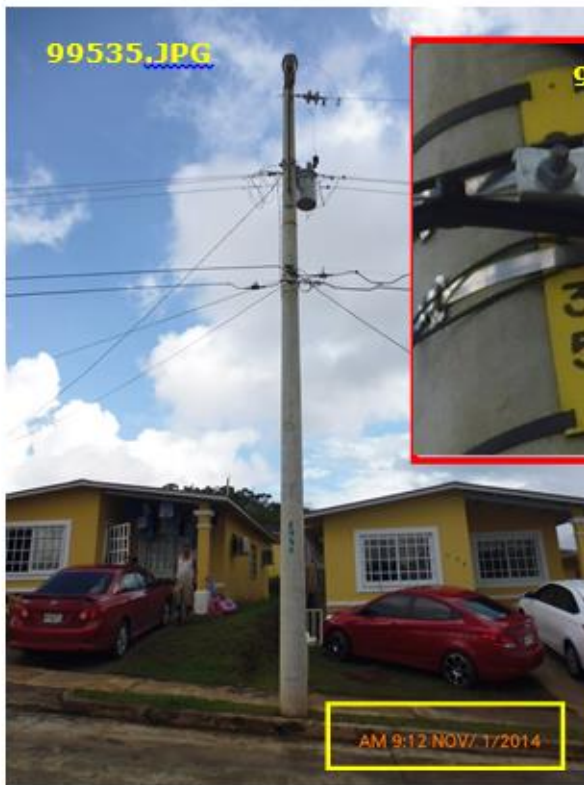
Figura 1 - Foto Panorámica poste completo
