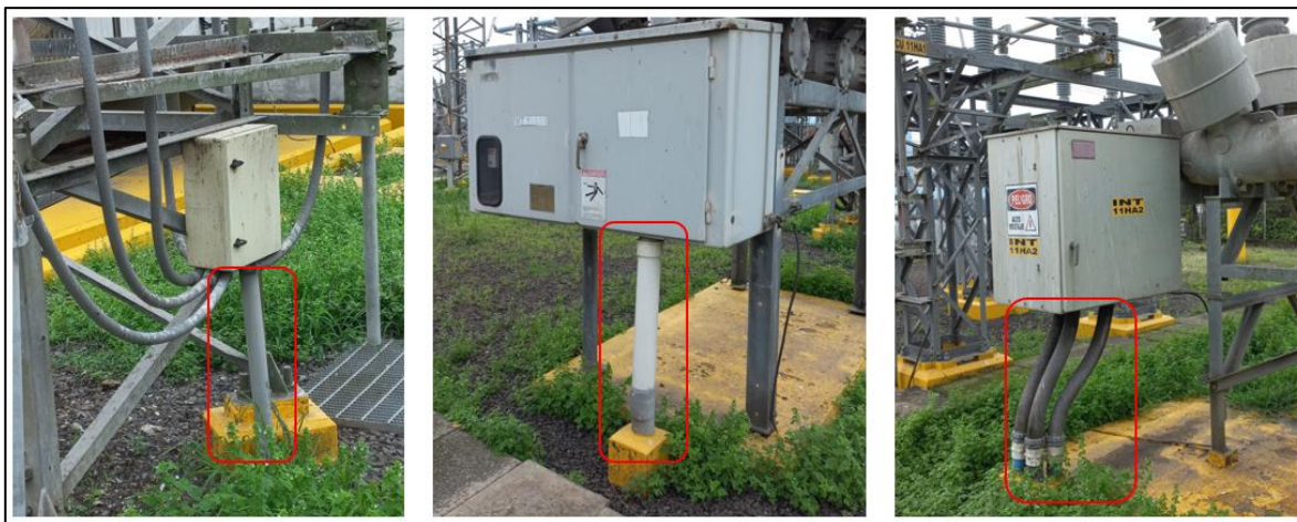
Imagen 6.3.1.3: Acceso a cajas de cuchilla e interruptor en patio de 115kV
