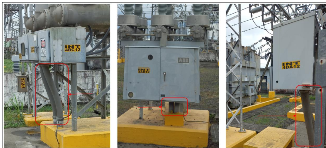
Imagen 6.2.1.8: Tuberías disponibles en las cajas de interruptores de 44kV
