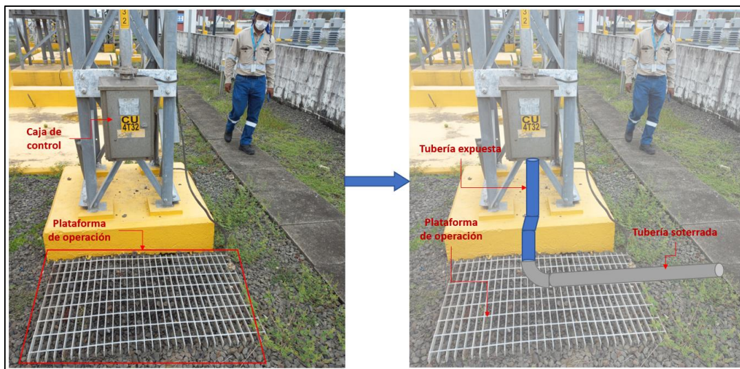
Imagen 6.2.1.4: Concepto de instalación de tubería para CU 4T32
