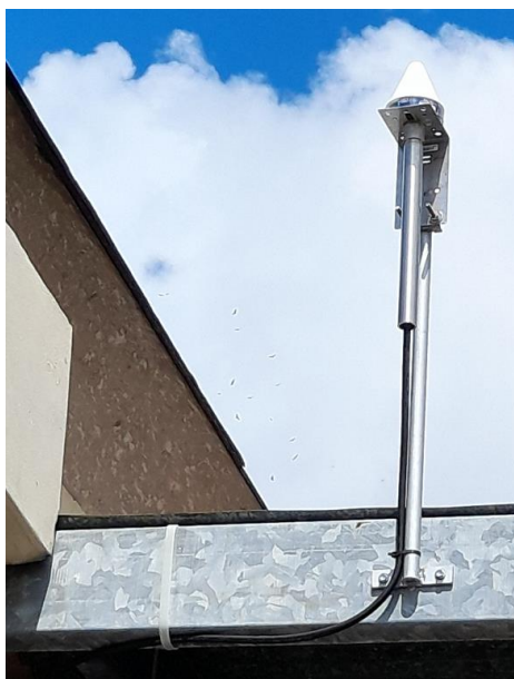
Imagen 6.13.5.1: Antena GPS correctamente instalado en una subestación de ENSA.
