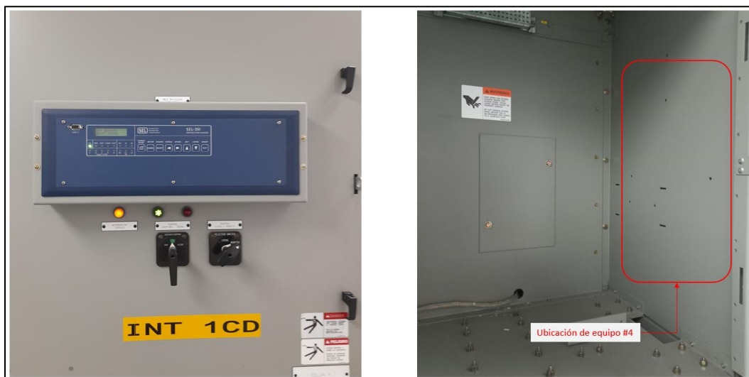
Imagen 6.8.1.4: Posible ubicación de equipo de automatización para EMB5 (IO09)
