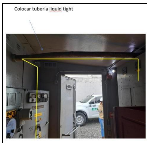
Imagen #3.3: Recorrido de fibra en metalclad 2.
