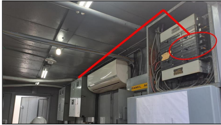
Imagen #3.8: Recorrido de cable de alimentación DC en 48V.
