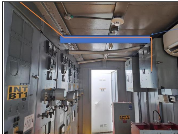
Imagen #3.7: Recorrido de fibra óptica y ubicación de caja de medidores en metalclad 3.
