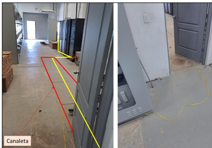
Imagen #1.2: Recorrido de la fibra óptica en la canaleta de la caseta.
