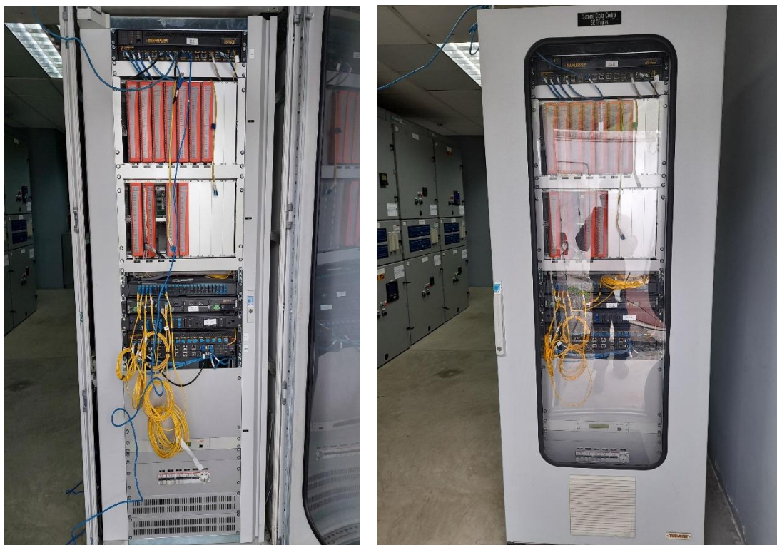
Ilustración 1 RTU Telvent subestación Tinajitas
