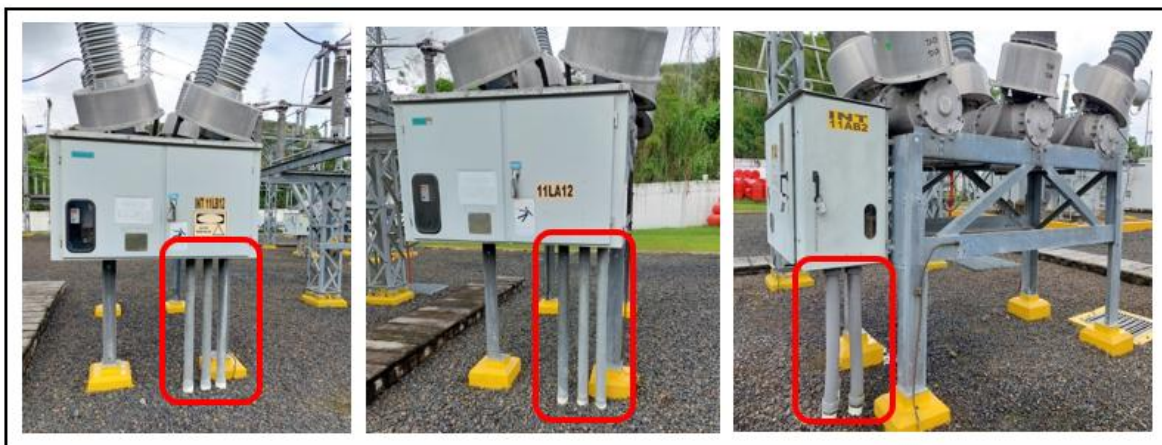
Ilustración 21 Tuberías disponibles en las cajas de los interruptores de 115kV
