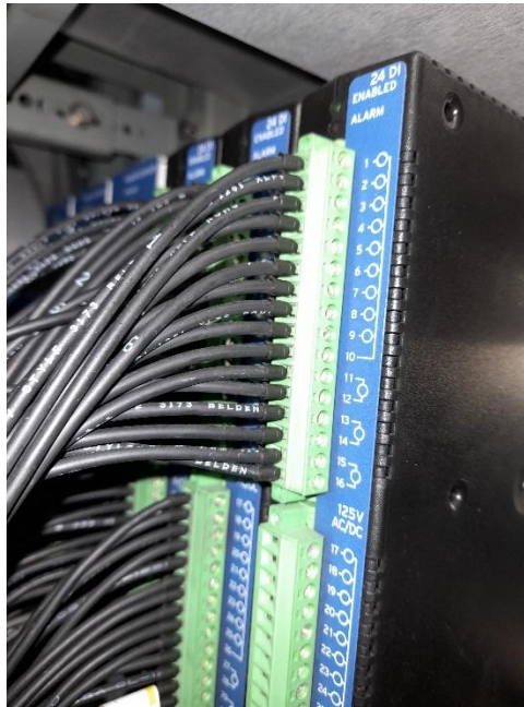
Ilustración 50 Cableado del AXION proveniente de la "caja de paso".
