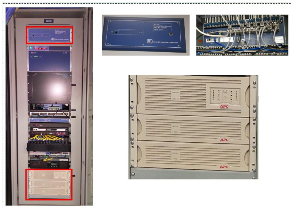
Ilustración 52 Equipos a retirar del gabinete de comunicaciones existente.
