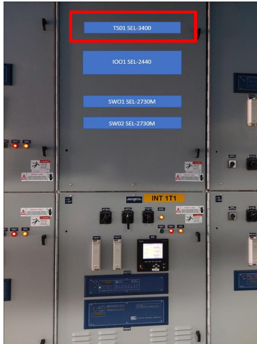
Ilustración 29 Concepto de instalación para el TS01
