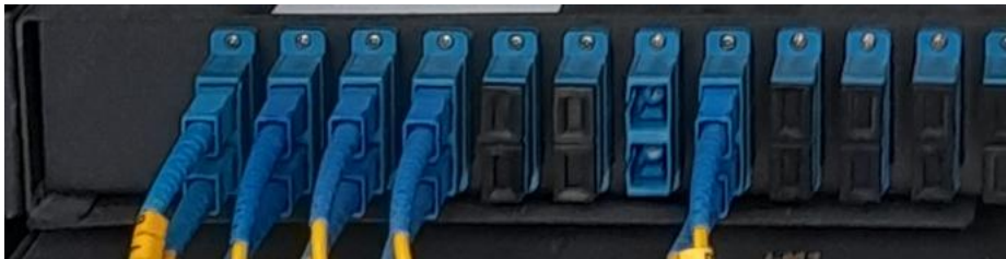
Ilustración 32 ODF tipo de atornillable.
