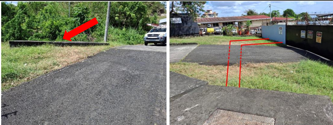
Ilustración 6 Cámara existente y bosquejo de nuevo vigaducto.
