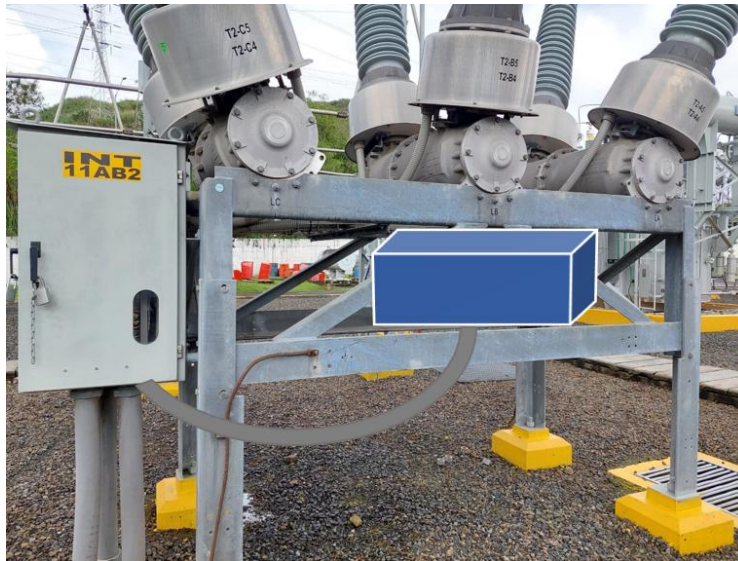
Ilustración 16 Concepto de instalación de las cajas en interruptores de patio de 115kV
