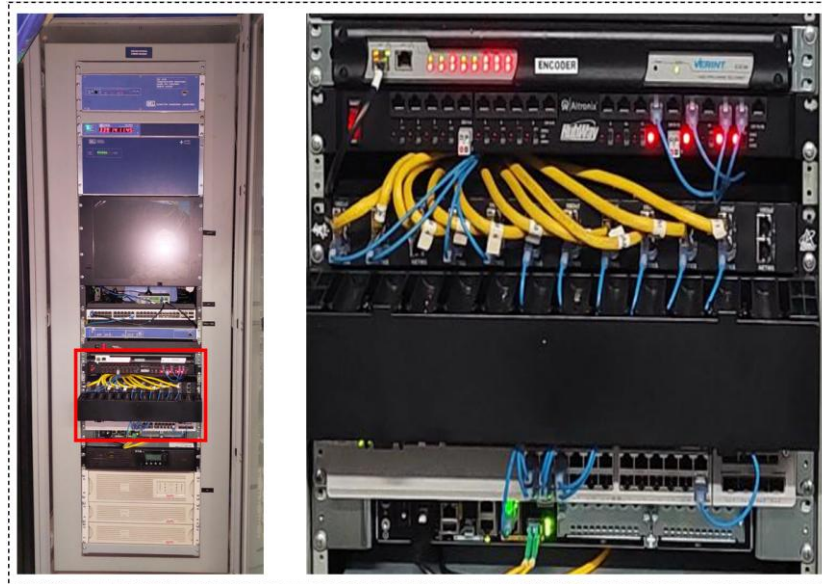
Ilustración 53 equipos a reubicar del gabinete de comunicaciones existente.
