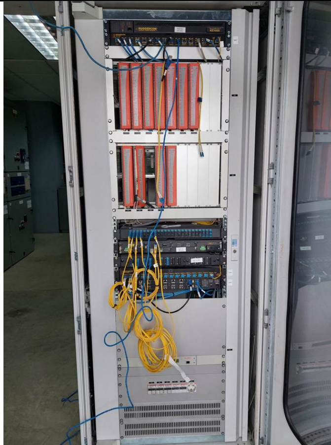
Ilustración 55 Gabinete de comunicación TELVENT en el EMB2.
