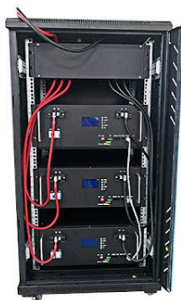
Ilustración 10 Banco de baterías de 48Vdc
