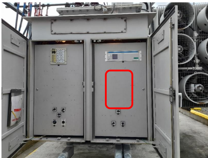
Ilustración 23 Concepto de instalación del SEL-2411 transformador 2
