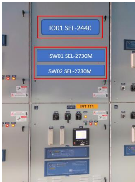
Ilustración 27 Instalación del SW01 y SW02
