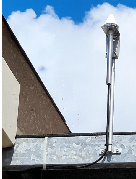
Ilustración 47 Instalación de antena GPS
