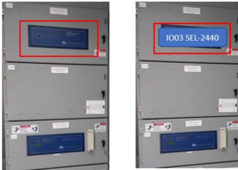
Ilustración 26 Instalación del IO03
