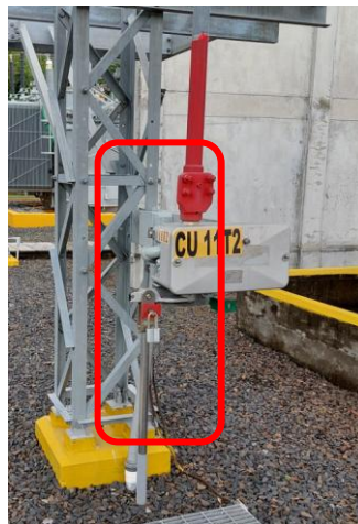
Ilustración 19 Tubería existente en cuchilla 11T2
