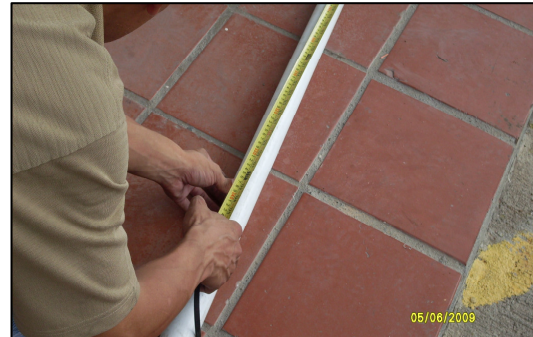
Figura #7. Luego de cortar los 20' de tubería se recomienda medir las distancias especificadas en las tabla 1, 2 y 3.
