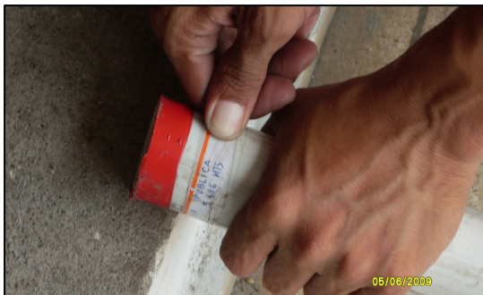
Figura #6. Se debe señalar con cinta aislante o con un marcador las diferentes distancias especificadas en la tabla 1, 2 y 3.
