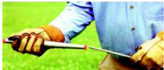
**Figura N°12. Medir Extremos del Conductor.**
