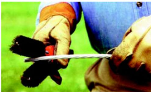
**Figura N°10, Inspección y Limpieza del Conductor.**
