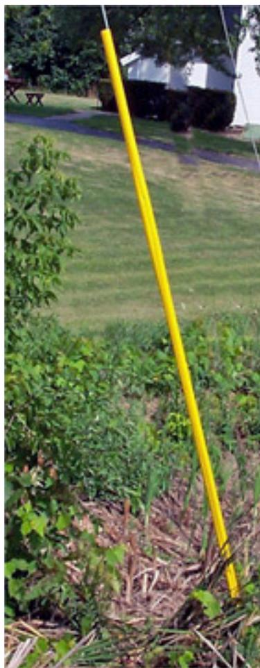
**Figura N° 7. Cubierta Protectora para Retenidas**
