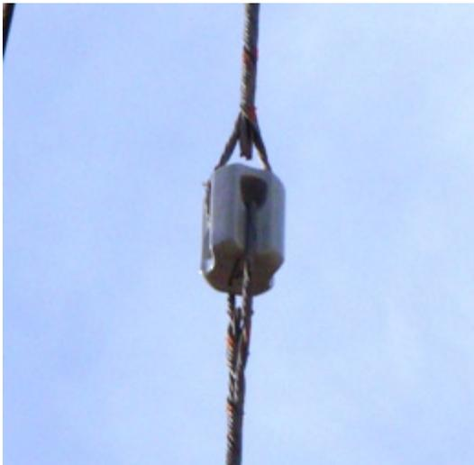
**Figura N°4. Aislador tipo tensor**
