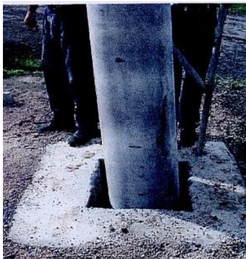
Figura N°7, Cimentación para Poste Auto Soportado
